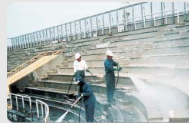
スタンドの洗浄 Cleaning of Stand
