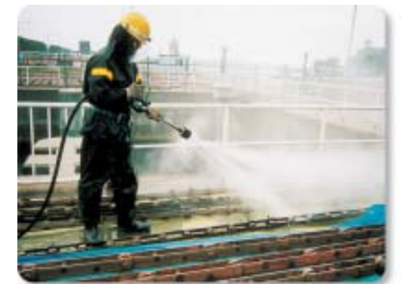
スクリーン用チェーンの洗浄 Cleaning Water Screen Chain
