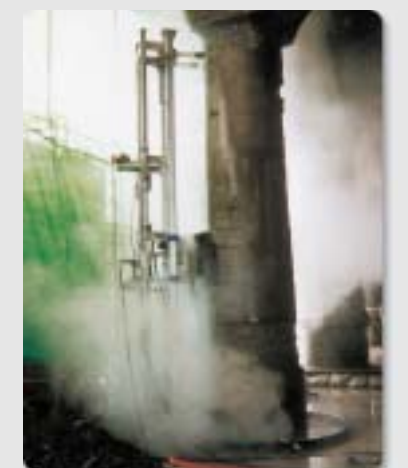
コンクリート支柱のはつり Chipping of Concrete Prop
