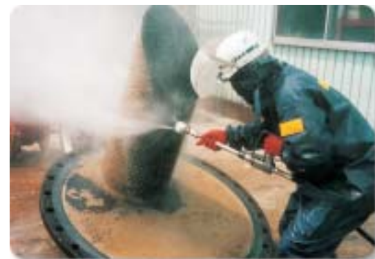
ストレーナの洗浄 Cleaning of Strainer
