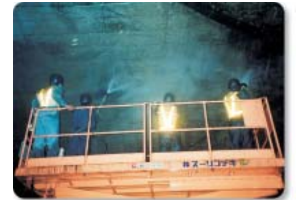
トンネルの内面洗浄 Cleaning of Inner Surface of Tunnel
